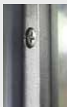
zusätzliches massives Stahlprofil 12x12 mm im Blendrahmenstahl verschraubt
