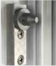
Bandseitensicherung (3-fach)
