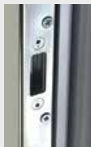
durchgehende Schließleiste im Blendrahmenstahl verschraubt
